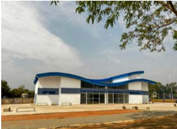
Fase final de obras para o tão aguardado Memorial Mokoí Yembu. Foto: PMDC
